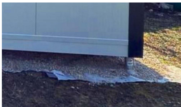
Detail spodnej hrany dokončenej stavby na zemných vrutoch.
